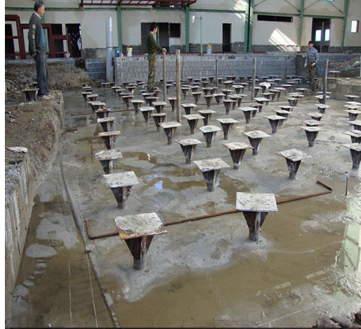
شکل ۱: نمونه ای از اجرای ریزشمع [۱۲]
